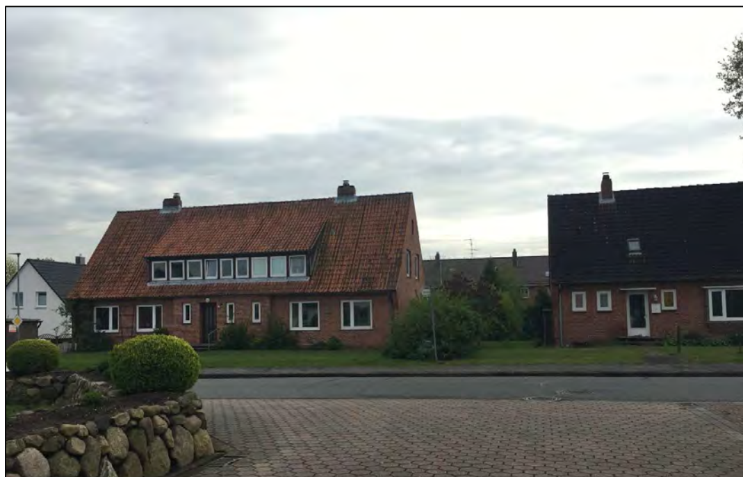
Abb. 3: Bestandsgebäude – Blick aus Richtung Rotdornallee auf das Plangebiet
