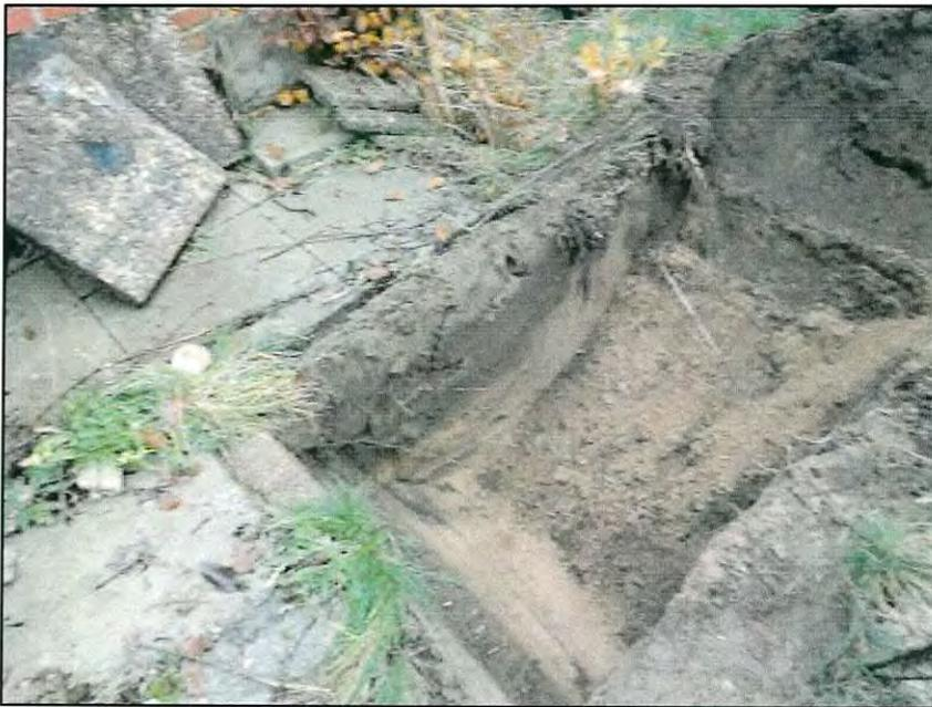
Abb. 3: Bodenschichtung im Schurf 2 mit Mutterboden über gewachsenen Sanden
