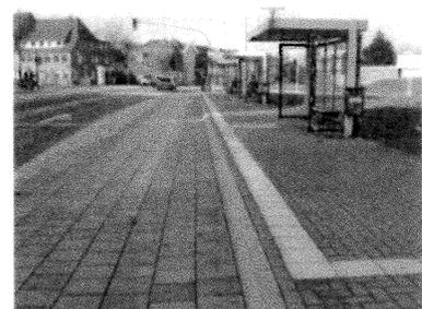
*Abb. 35/ Abb. 36: Hochbord und Bodenindikatoren bei beengten Platzverhältnissen (in Eckernförde) – Aufmerksamkeitsfeld fehlt hier*
