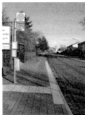
Abb. 31: Hochbord-Haltestelle mit Bodenindikatoren, aber beengtem Rad-/Fußwegbereich/ konfliktträchtiger Radwegführung
