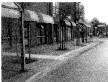
Abb. 33 (links)/ Abb. 34 (rechts): Hochfrequente Hochbord-Haltestellen mit Bodenindikatoren und Wartehallen (Abb. 33 in Eckernförde, Abb. 34 in Rendsburg)
